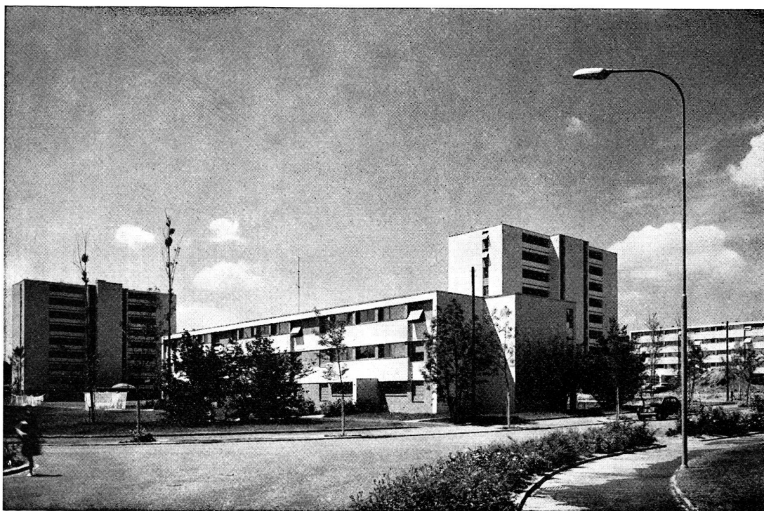
Les deux maisons à huit étages, à gauche celle de l'ASIG, à droite celle de la ROTACH.
