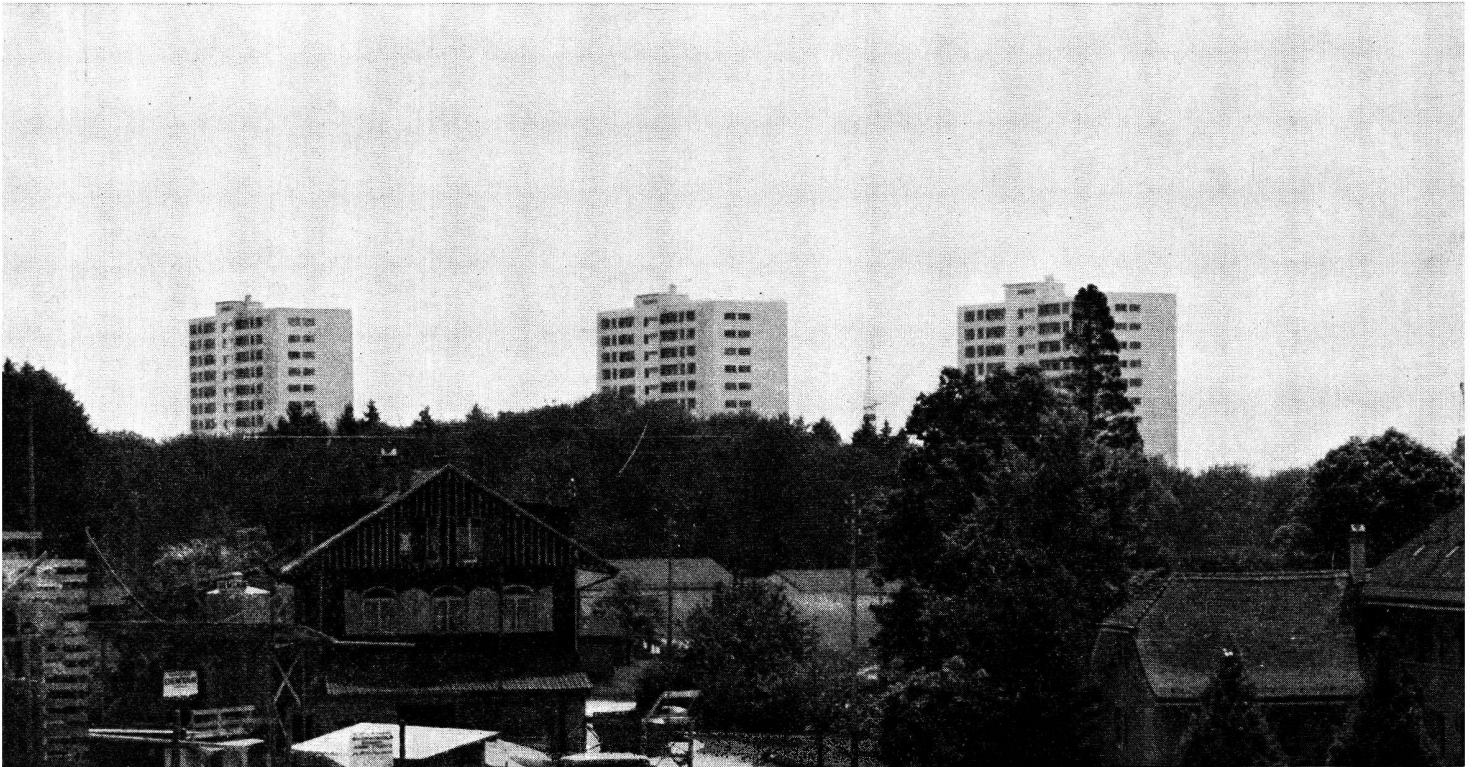
Lausanne: Les trois tours de Valmont, vues du nord-ouest.
