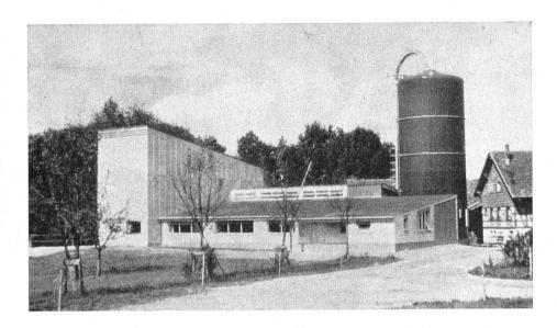
Au milieu: Autre exemple de l'architecture fonctionnelle, où la forme des éléments accuse nettement la destination: au premier plan, l'étable; au fond, le volume pour la paille et le fourrage; à droite, un silo préfabriqué en éternit, dans lequel le foin haché est entreposé et aéré, pour être transporté mécaniquement vers les crèches. Ferme près de Basadingen (ZH), 1961, projet SVIL.
