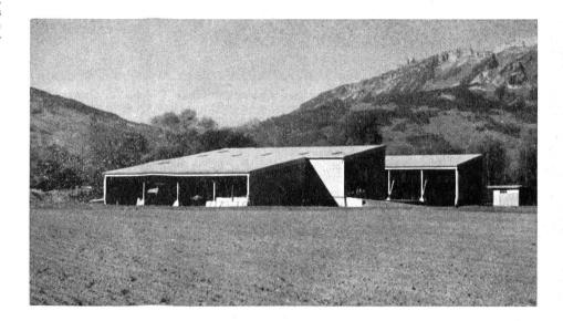
En bas: La «gare» d'une exploitation moderne doit abriter les véhicules et les engins coûteux, elle doit être simple, pratique etacces ible sur toute la longueur. Les garages et les ateliers mécaniques sont entrés dans les habitudes. La construction, qui peutaisément s'agrandir, protège la cour du vent d'ouest. Hangar d'une ferme de la plaine de la Linth. Projet SVIL.
