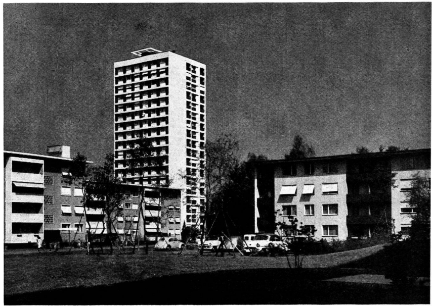
8 Le «Grünhof» (Architecte: Jos. Beeler, Zurich)
