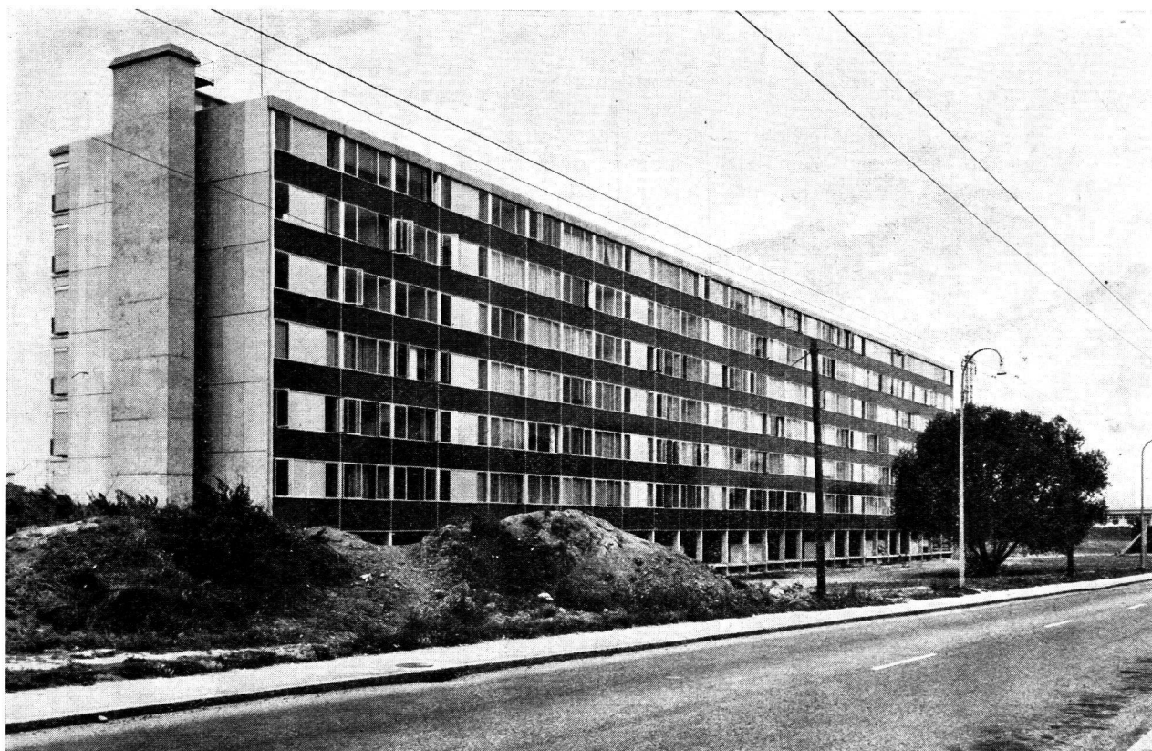
L'immeuble de la Société coopérative « Les Ailes » est intéressant à plus d'un titre et s'insère dans un ensemble en voie de réalisation
