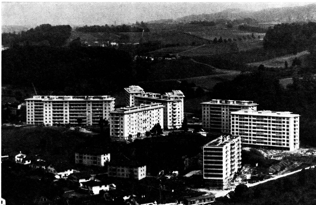
Le quartier de Mont-Goulin, à Prilly-Lausanne: cette juxtaposition inharmonieuse de gros immeubles discutables n'est, hélas, en aucune manière, un quartier au sens où l'entendent les urbanistes.
