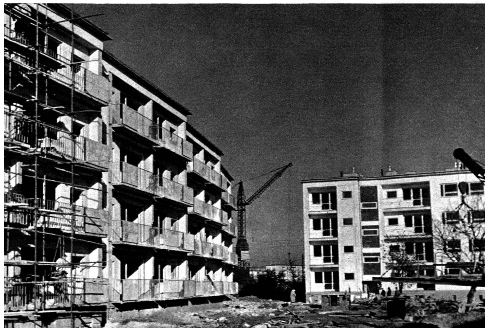
1 et 4 Immeubles préfabriqués à Wierzbno (M me Fafius, architecte). 2 et 3 Montage d'éléments du groupe «Kasprzak».
