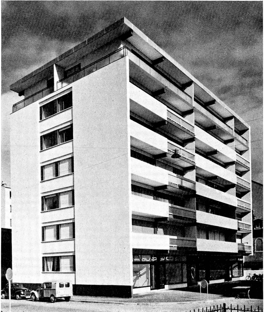
Immeuble rue des Buis 8-rue Gautier. 1957-1958. Architecte : M. Pierre Borsari.
