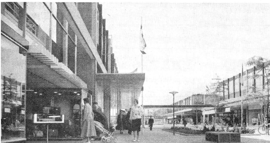
Fig. 32 Centre de magasins de «Lijnbaan». (van den Broek et Bakema.)
