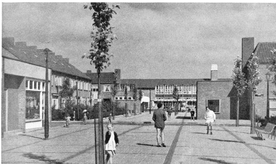
Fig. 20 Habitations et magasins de quartier situés autour d'une place pour piétons.
