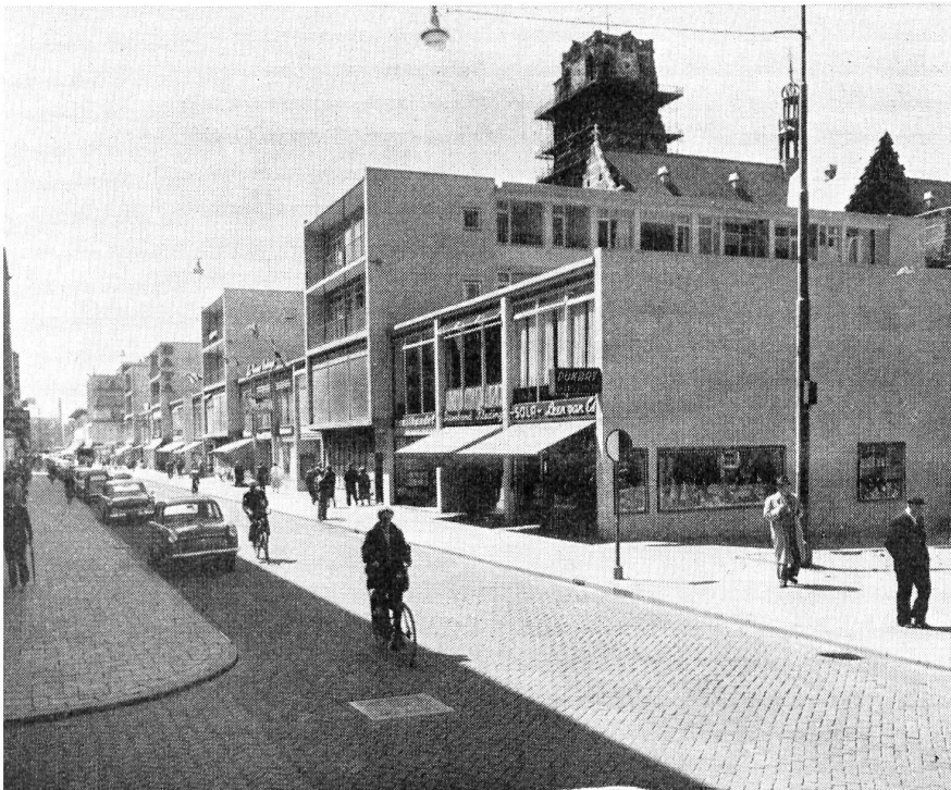
Fig. 28 Rue de magasins avec vue sur l'église de Saint-Laurent, dévastée en 1940 et restaurée.
