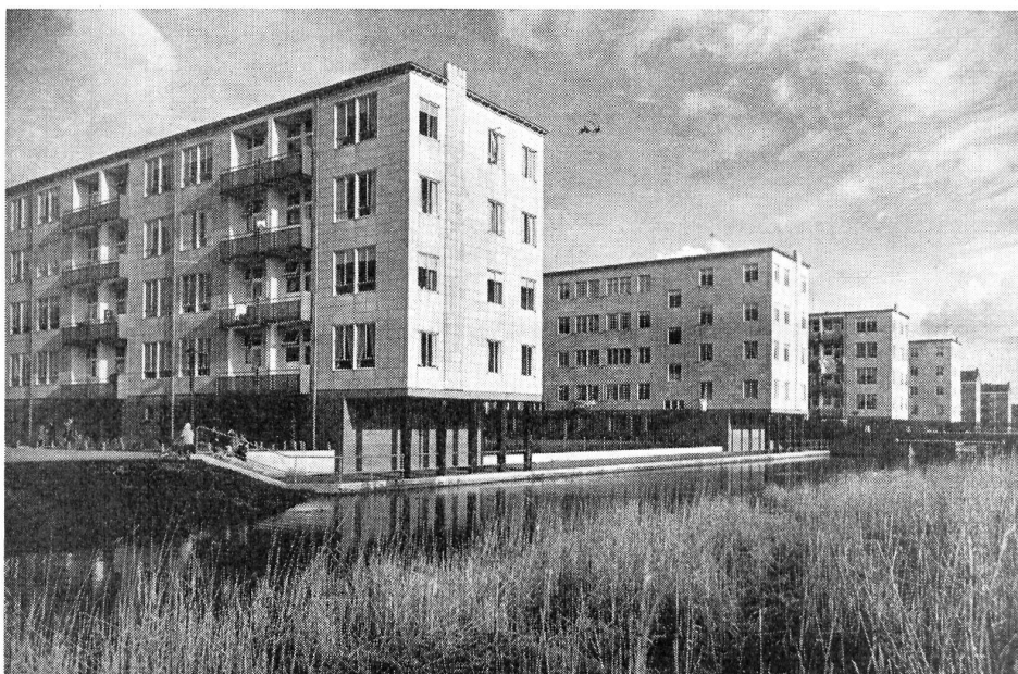
Fig. 16 Constructions d'habitations à plusieurs niveaux en éléments préfabriqués.
