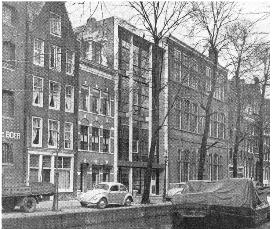
Fig. 22 Implantation de bâtiments modernes parmi des bâtiments anciens. En ce qui concerne le raccordement de nouveaux édifices à ceux qui existent déjà, l'imitation des styles est rejetée en tant que système. Echelle et rythme de l'aspect de la ville sont déterminants pour l'appréciation des plans.
