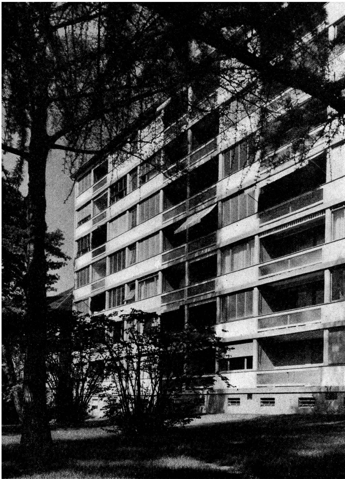
C. et F. Brugger et P. Bonnard. Bâtiment locatif au chemin de Lucinge, Lausanne. (Photo Bischoff.)
