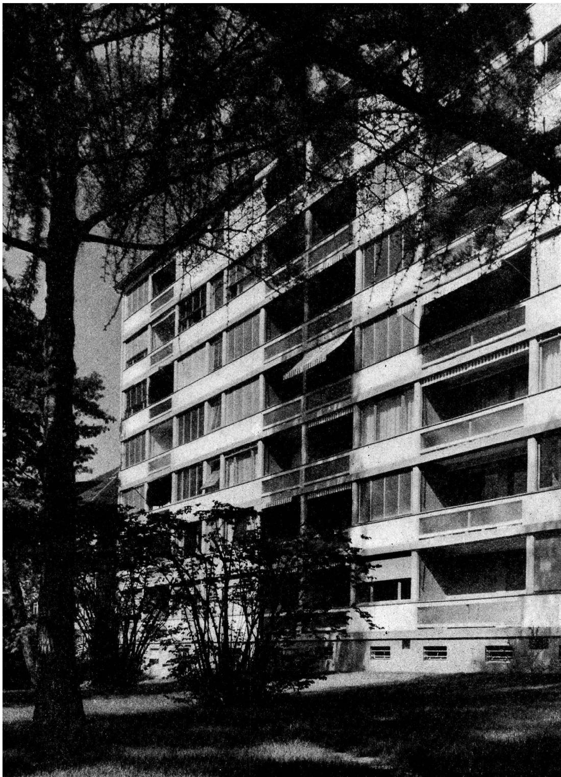
C. et F. Brugger et P. Bonnard. Bâtiment locatif au chemin de Lucinge, Lausanne. (Photo Bischoff.)
