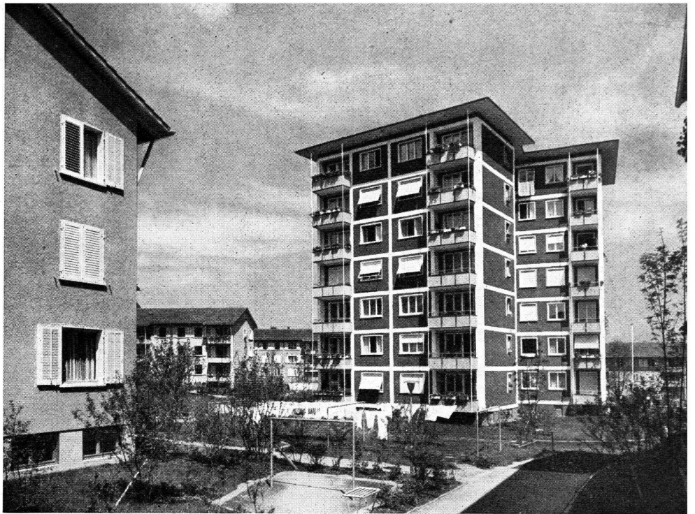
Cité d'habitations « Im-Moos », Zurich. Maître de l'ouvrage: « Allgemeine Baugenossenschaft Zürich, A. B. Z. » Eschlimann & Baumgartner, architectes. Cette cité comprend vingt-neuf maisons de différents types, dont cette « maison-tour », deux cent un logements, deux magasins de vente, deux jardins d'enfants, neuf garages. Vue de la maison-tour au sud. (Cliché Das Wohnen.)
