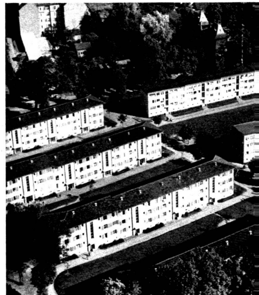
Surfaces libres vues à la Cité Vieusseux, à Genève. Photo
