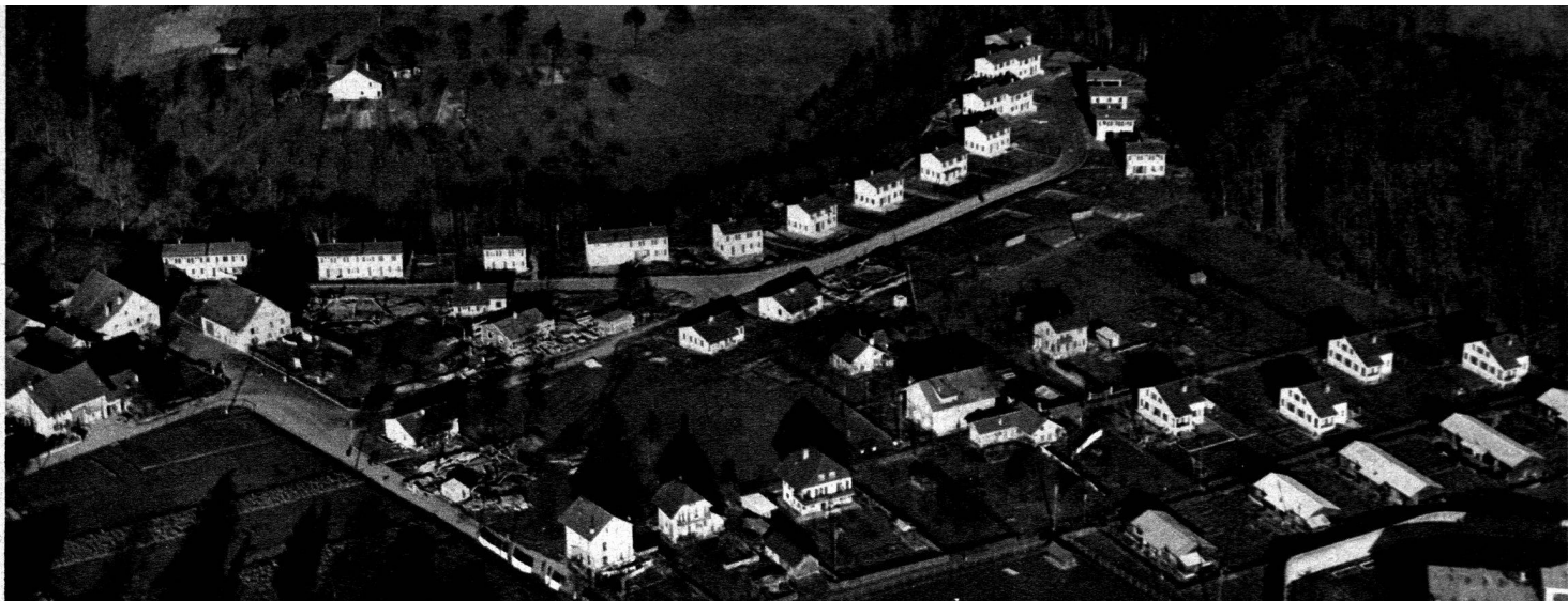
Vue aérienne pendant la construction. (Photo A. Würbler.)
