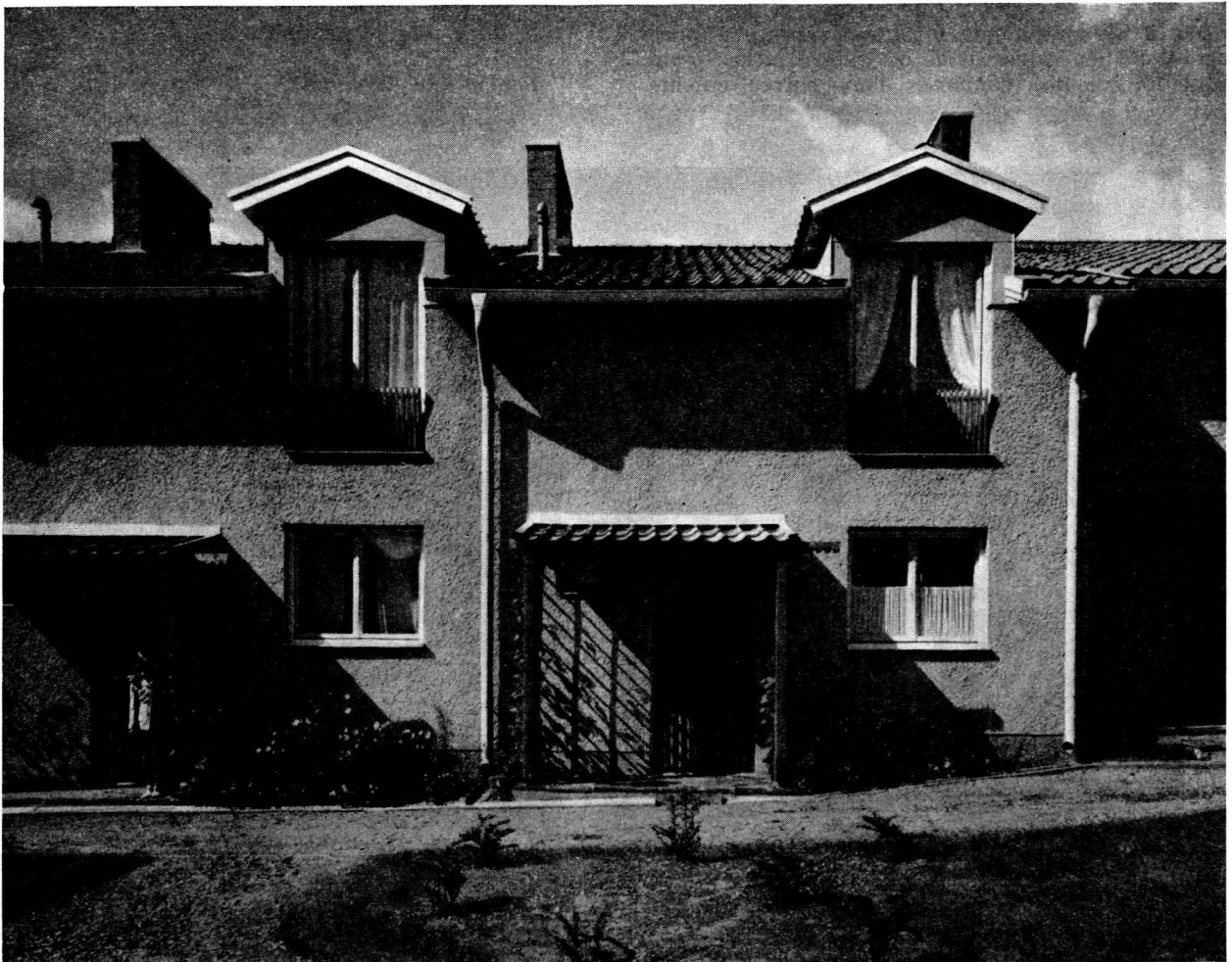
Maison suédoise en rangée pour famille nombreuse. Örebro. Architecte : Airi Viertokangas.
