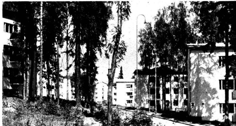
Vue générale depuis le centre de chauffage.
