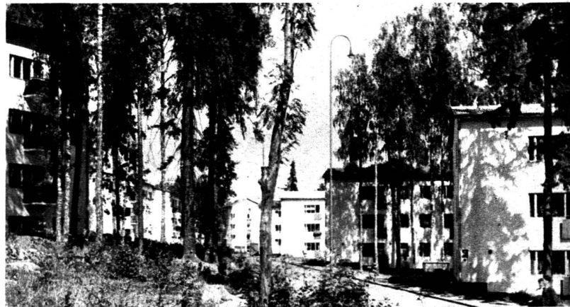
Vue générale depuis le centre de chauffage.
