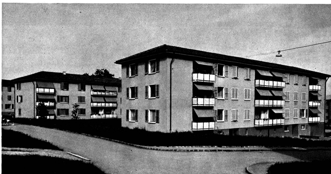
Les bâtiments N, O et P vus du sud-ouest.
