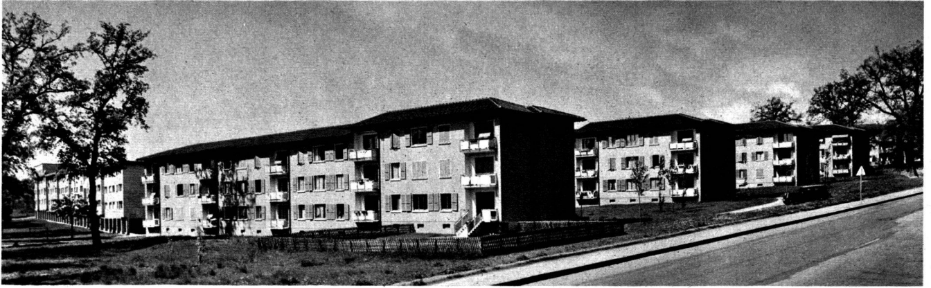
Ci-dessus: Vue d'ensemble de la route de Meyrin.
