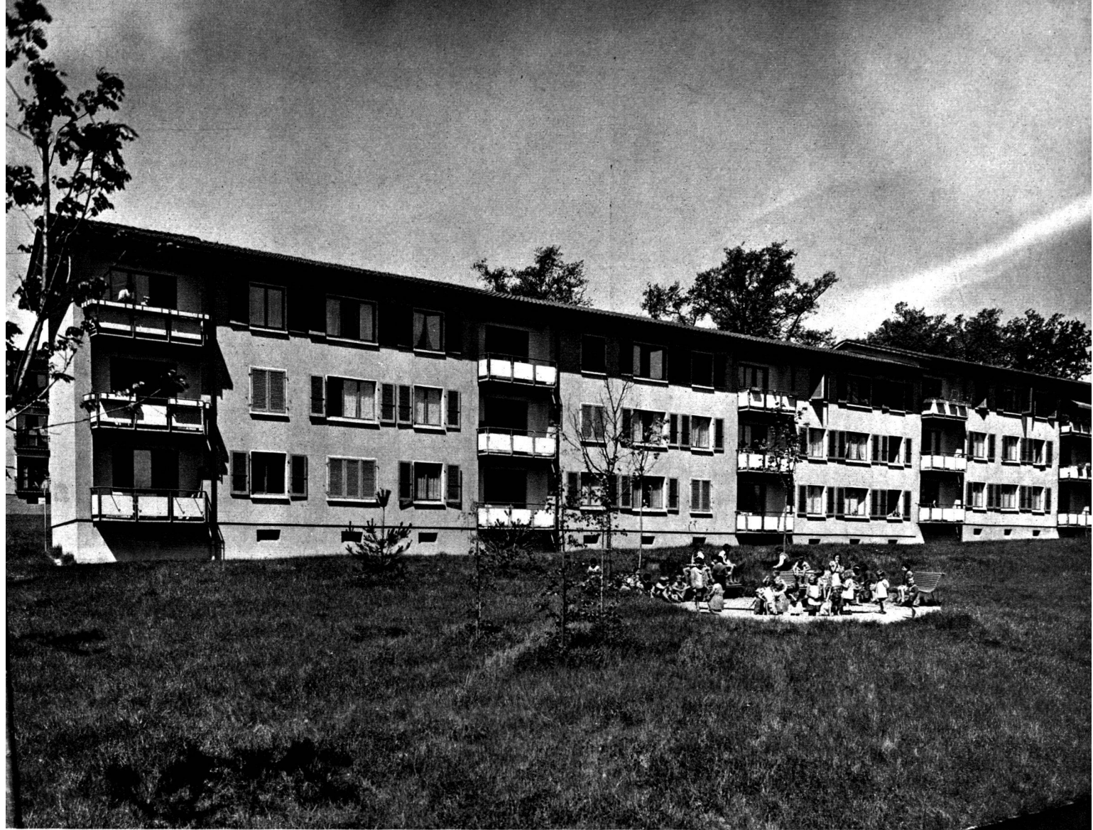
Un bâtiment de la première étape de Villars, vu du sud-est.
