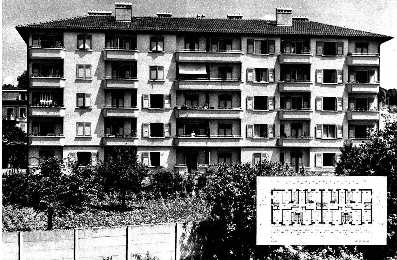
Façade principale de l'immeuble.
