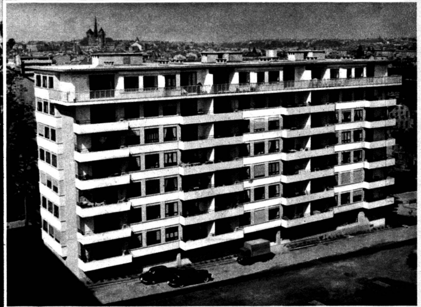
Le Groupe L, construit en 1948-1949. Façade sud-ouest.
