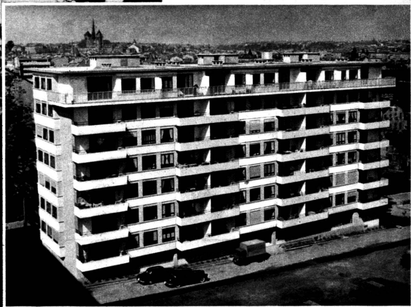
Le Groupe L, construit en 1948-1949. Façade sud-ouest.
