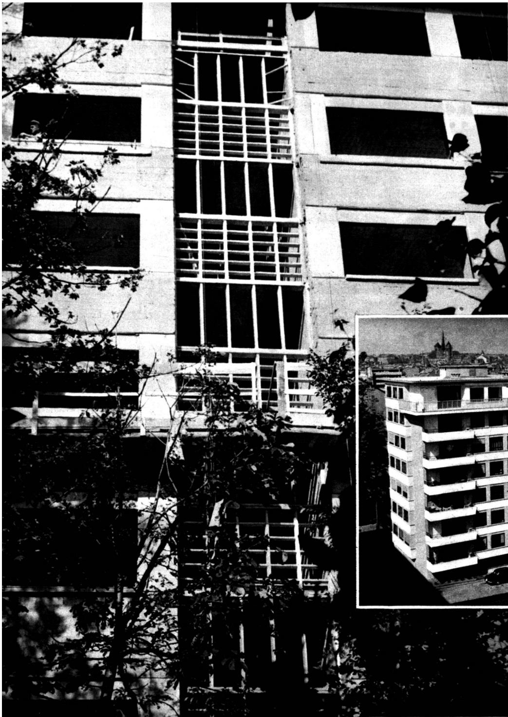
Groupe L, le vitrage d'escalier en éléments préfabriqués.
