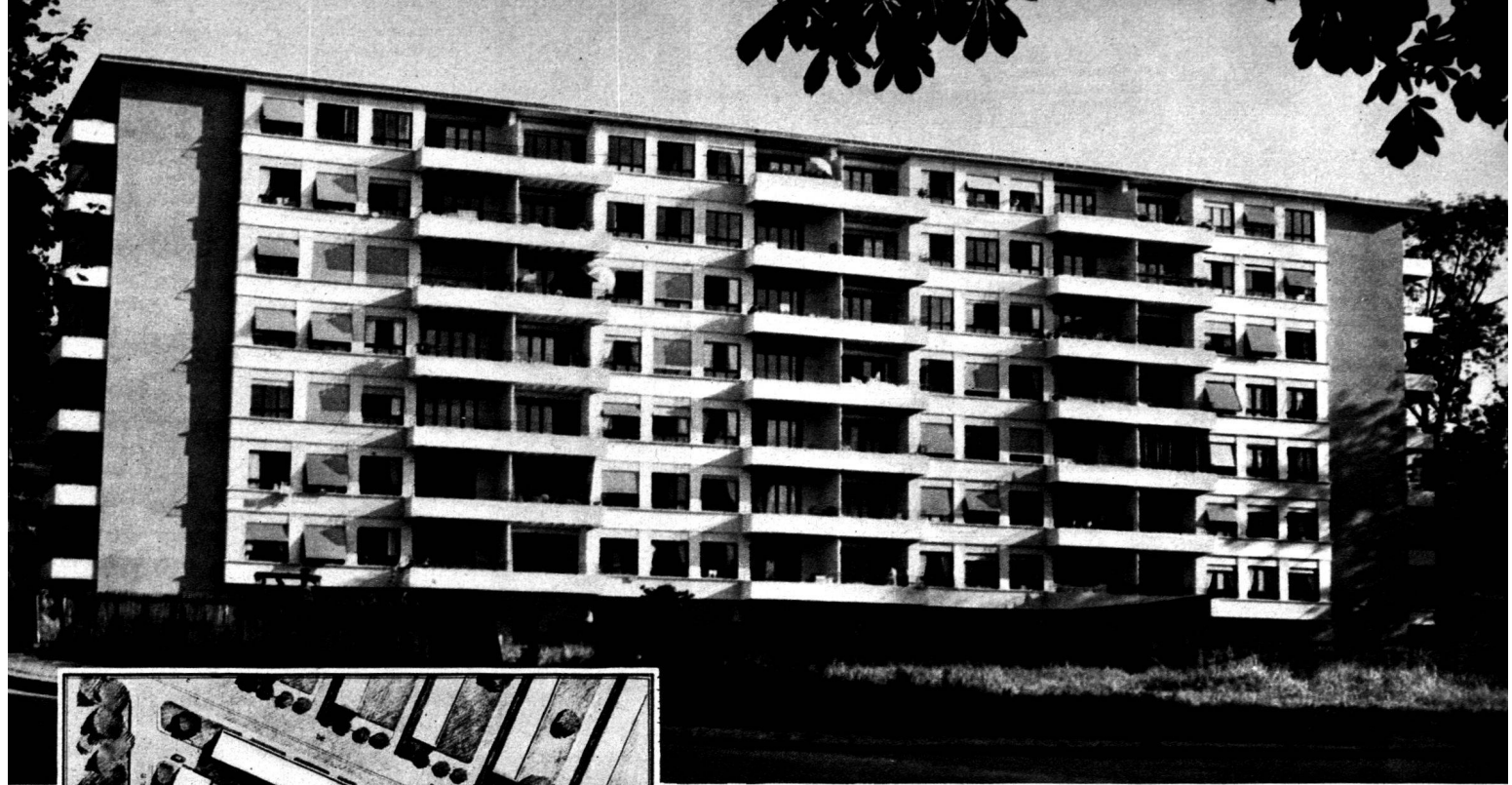
Immeuble du Groupe K, construit en 1947-1948. Façade sud-est.
