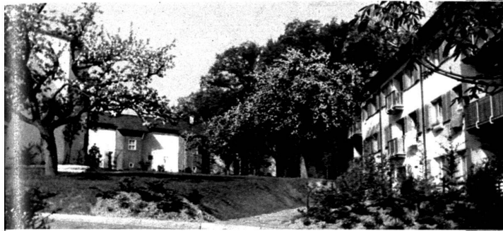
Les maisons du type A ont un escalier semi-extérieur.
