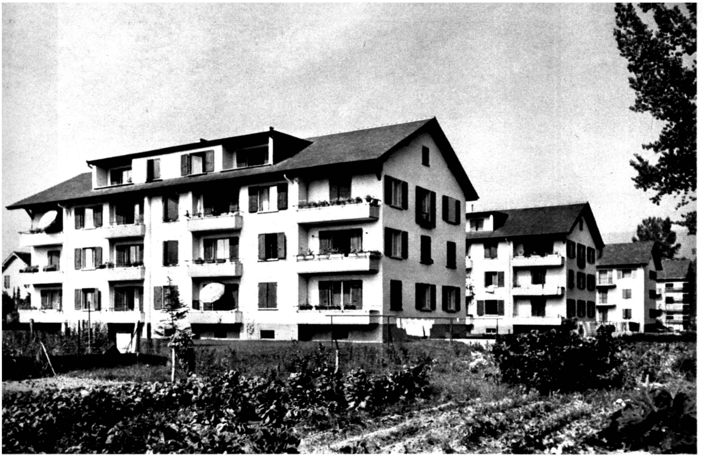
Vue générale de la cité d'habitation.
