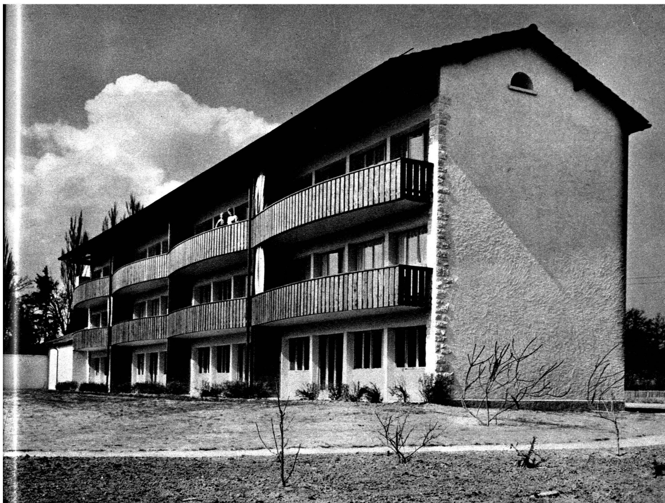
Vue côté galeries.
