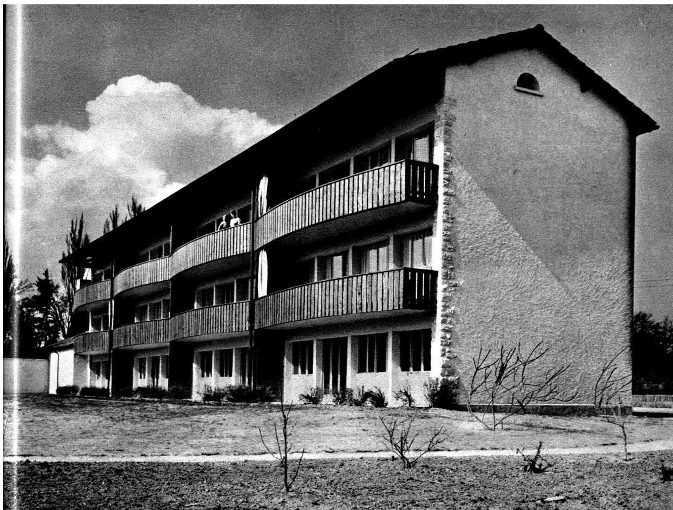
Vue côté galeries.
