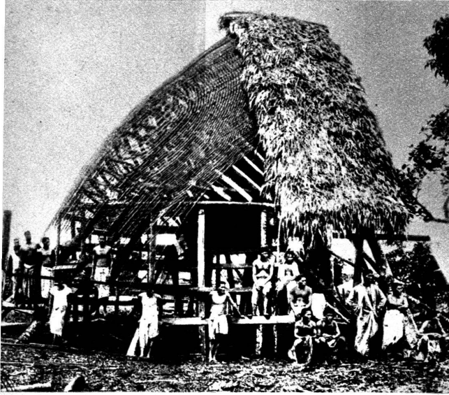
Construction d'une maison à Samoa. Tous les hommes du village s'assemblent pour construire un tel édifice. Aucun clou n'entre dans cette construction. Toutes les parties sont liées entre elles par des liens en fibres de noix de coco.
