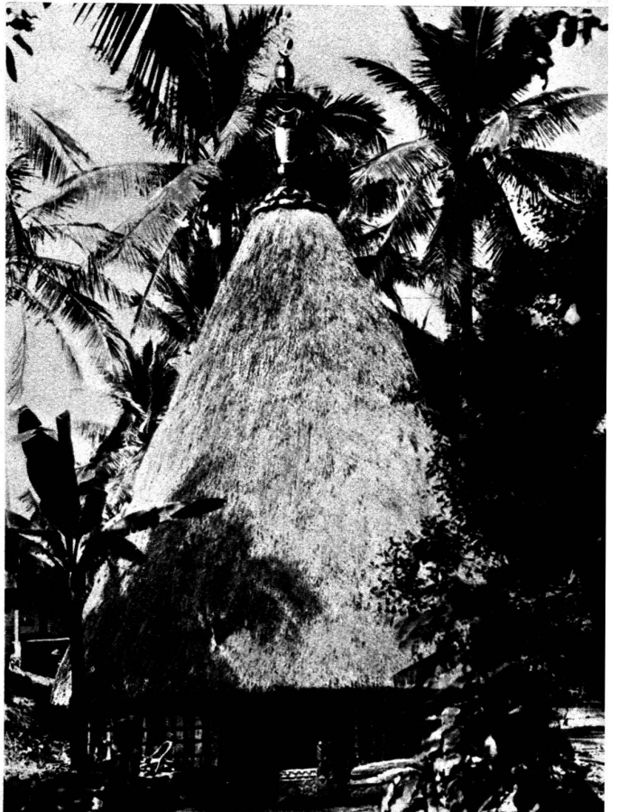
« Dubu Dacma » à Urama, Nouvelle-Guinée. Construction sur pilotis. Longueur environ 125 mètres. La hauteur, à l'entrée, est d'environ 25 mètres. (Stephen Chauvet, pl. 17.)
