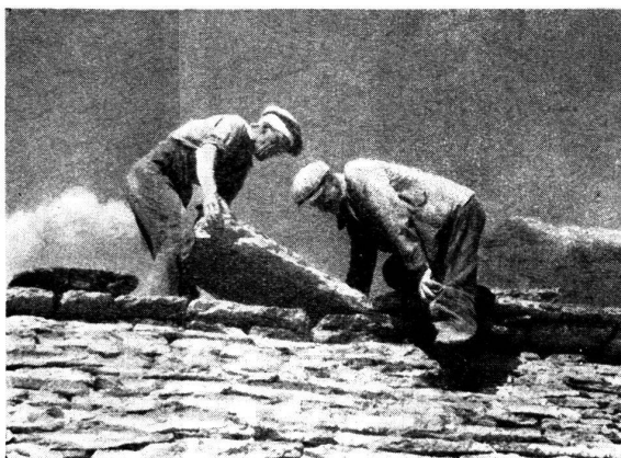
Pose des « tuiles » de pierre.
