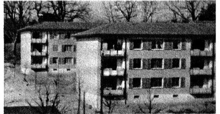
Un immeuble de la Cité Vieusseux.
