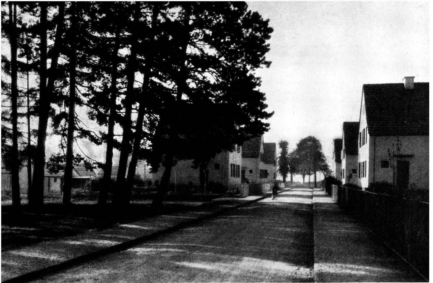
Un aspect de la cité-jardins de l'avenue d'Aïre : le chemin de l'Essor. A gauche, la place ombragée réservée aux jeux et à la promenade.
