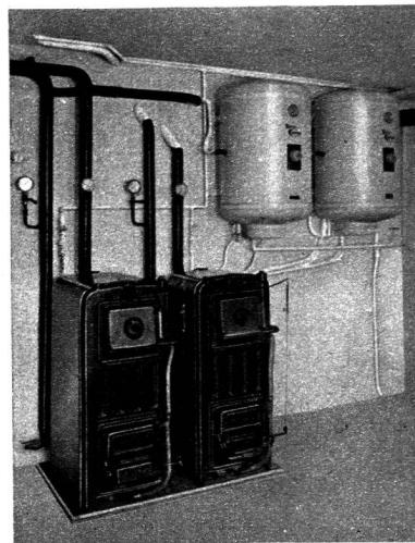
cuisson et service d'eau chaude ou chauffage central et service d'eau chaude mixte, fonctionnant tantôt par la chaudière, tantôt à l'électricité.
