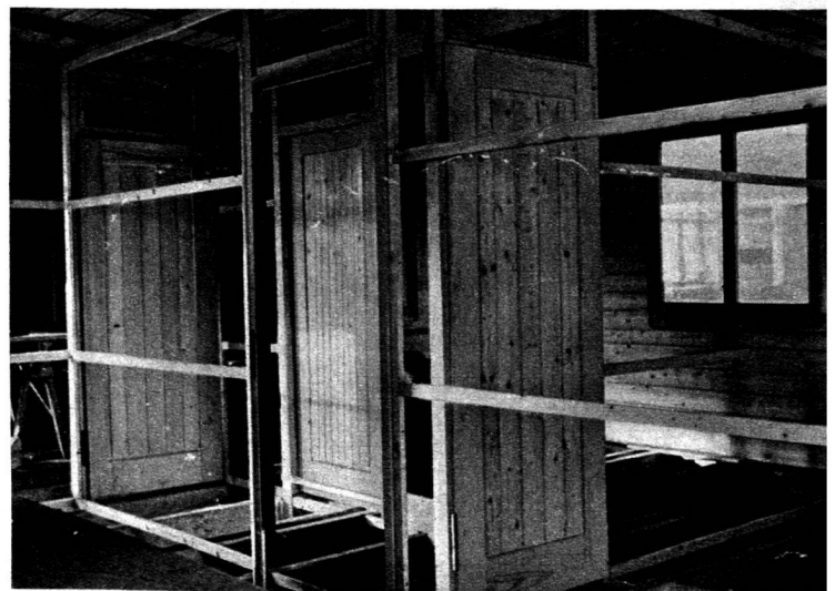
Ossature des parois intérieures.
