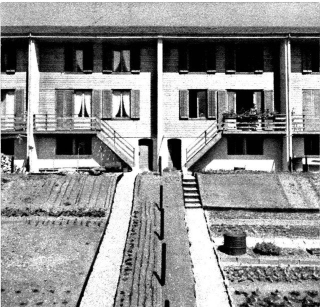
Façade sud groupe II, détail.
