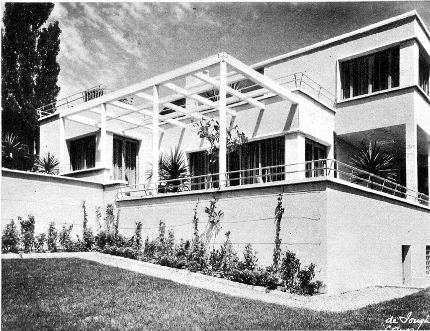
Vue du sud-ouest.
