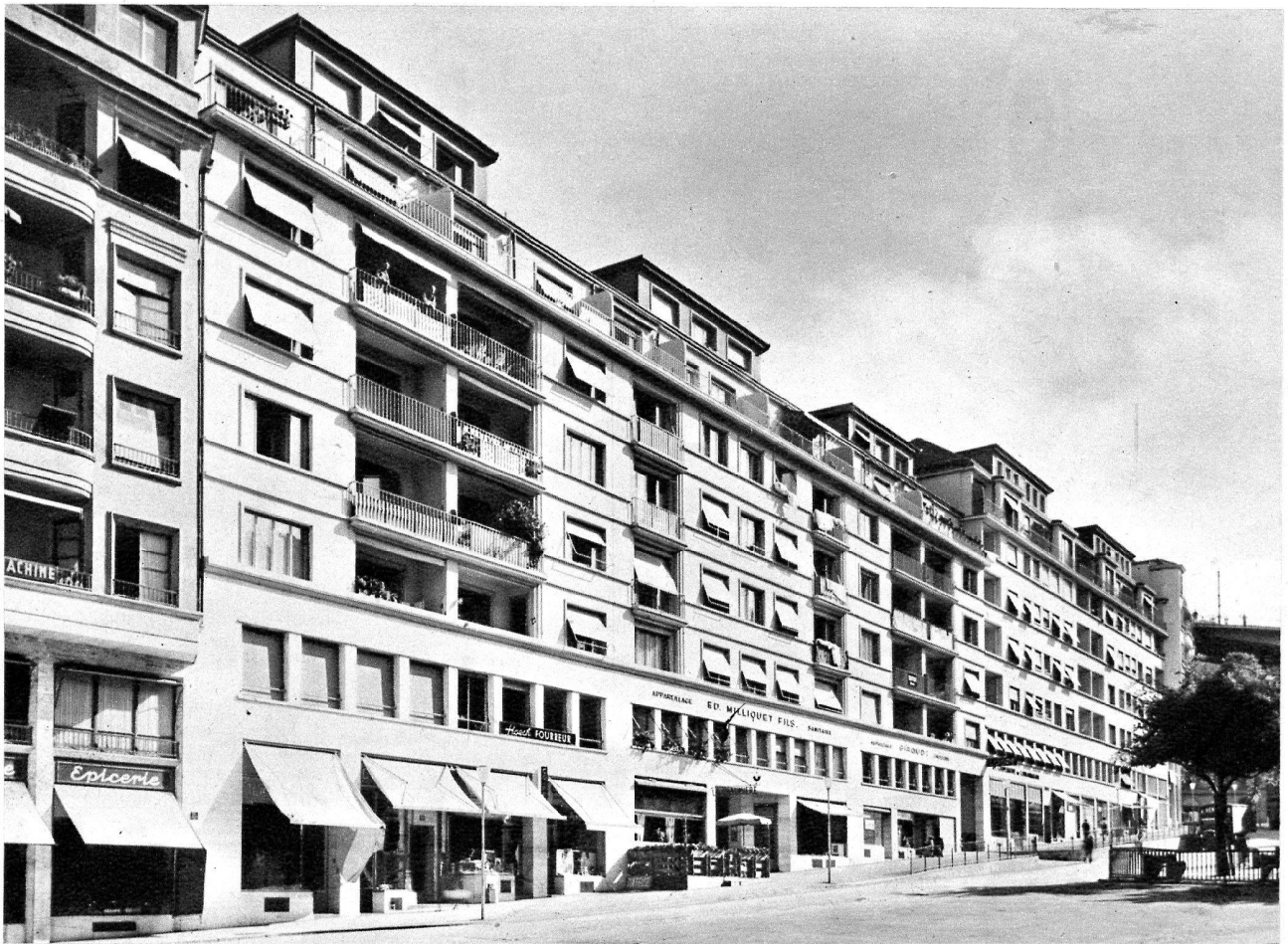
La nouvelle rue Centrale. Première étape de trois bâtiments.
