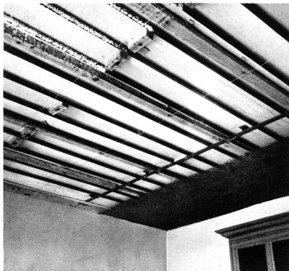
Installation de chauffage par le plafond en cours de montage.
