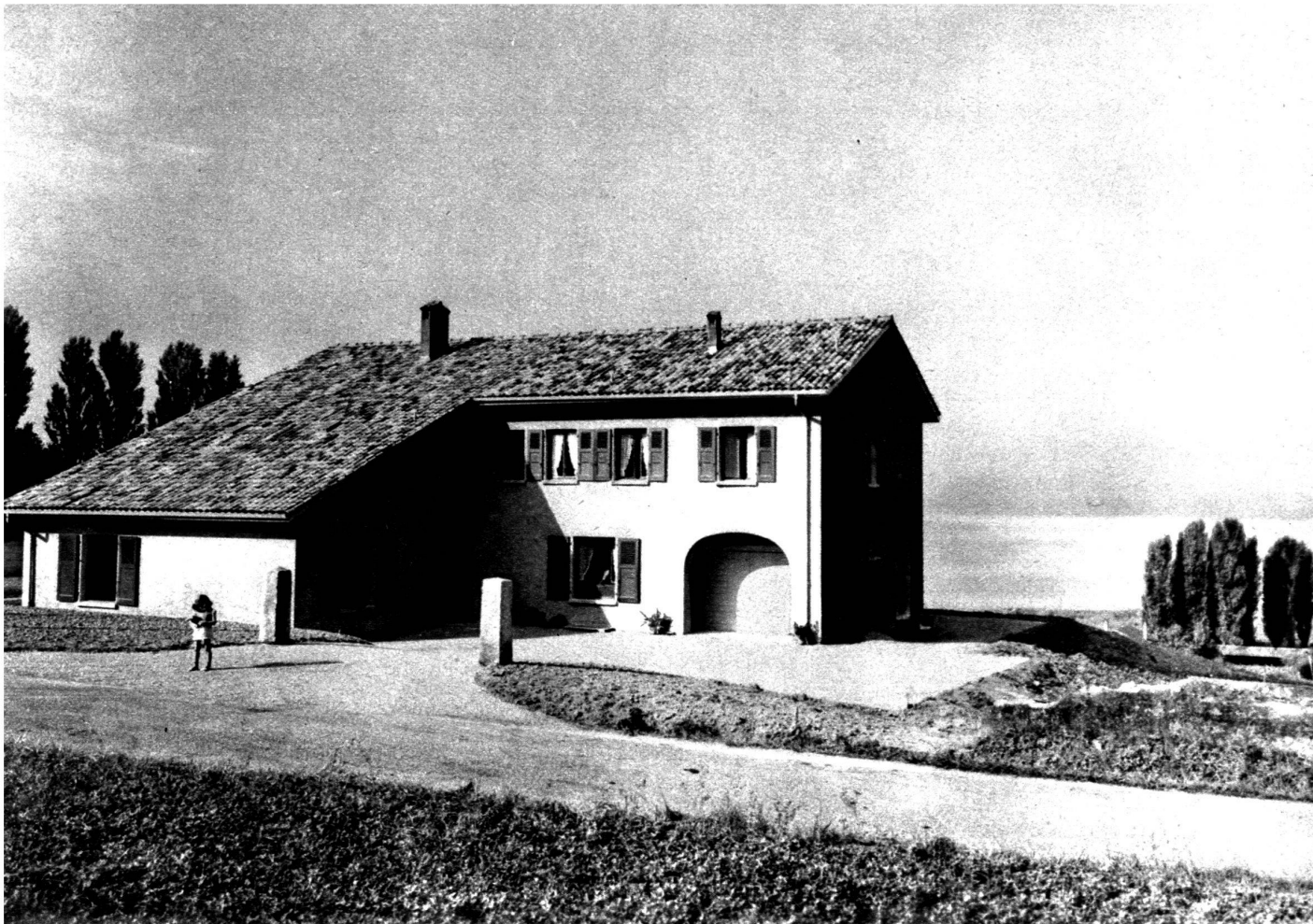
Vue côté route.
