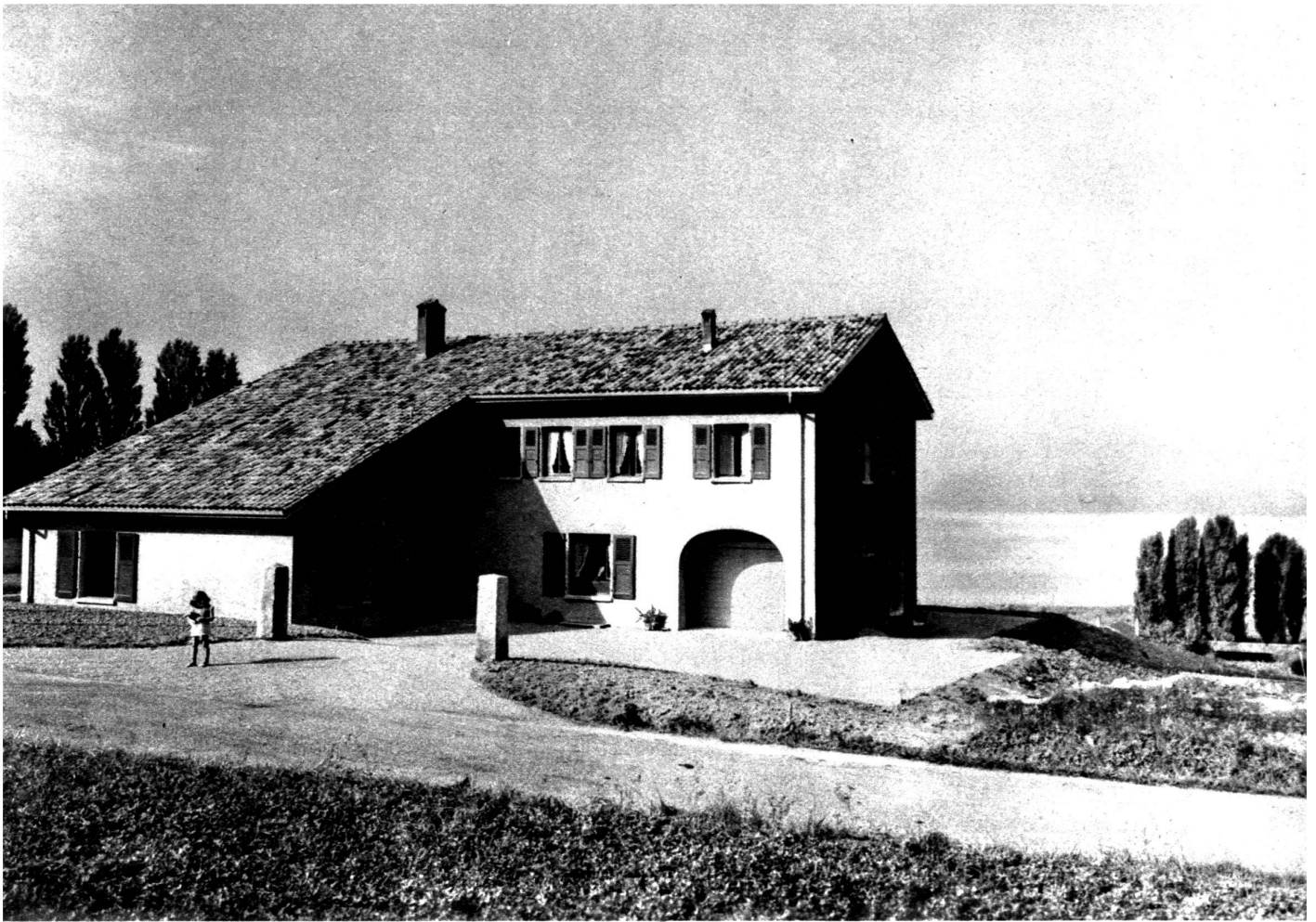
Vue côté route.
