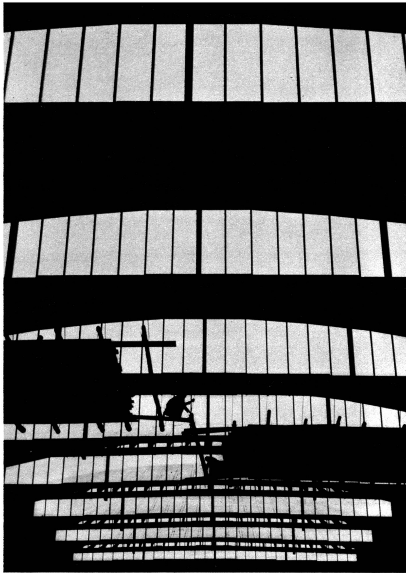
La toiture du Palais de la chimie.
