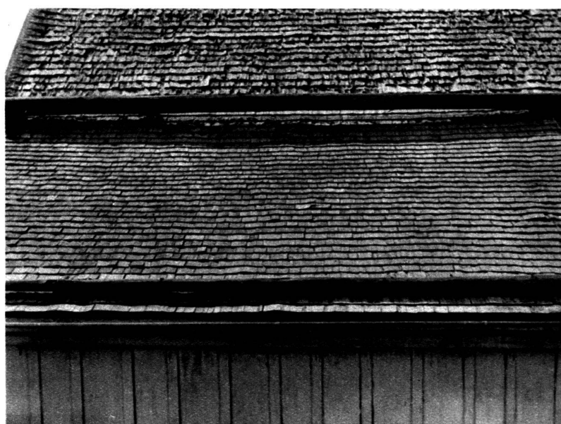
Utilisation des tavillons sur toiture avec barres à neige. On remarquera la différence entre les tavillons récents et anciens.
