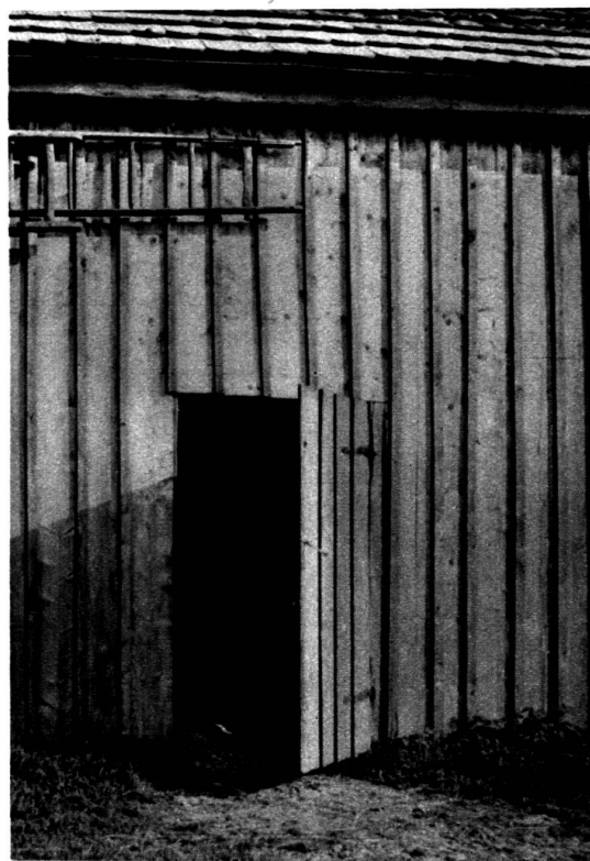
Revêtement en planches verticales avec couvre-joint. Cette disposition est également très répandue dans le Jura et la Savoie.
