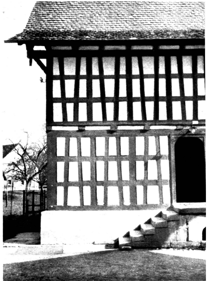
Un exemple de colombage (Egnach en Thurgovie).
