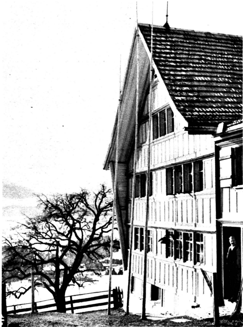
Ancien type de maisons en madriers avec revêtement de la façade sud en panneaux de bois. (Gais, canton d'Appenzell.)
