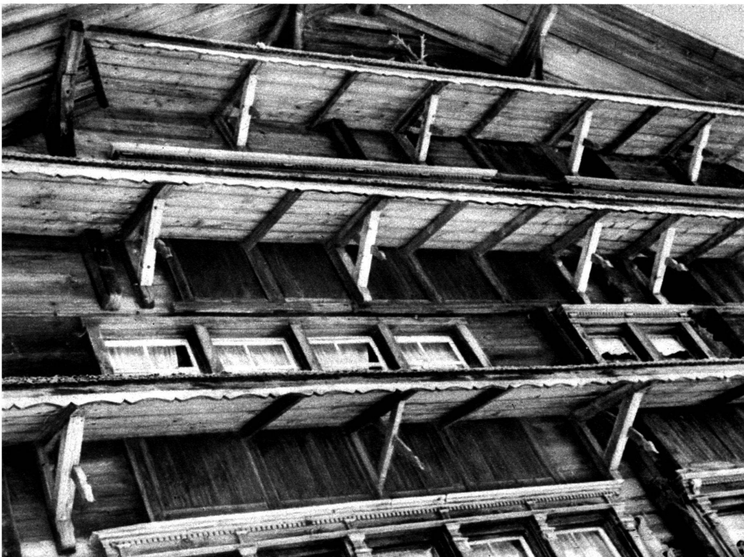
Les auvents sur les fenêtres constituent une excellente protection, mais qui a l'inconvénient d'assombrir les locaux.
