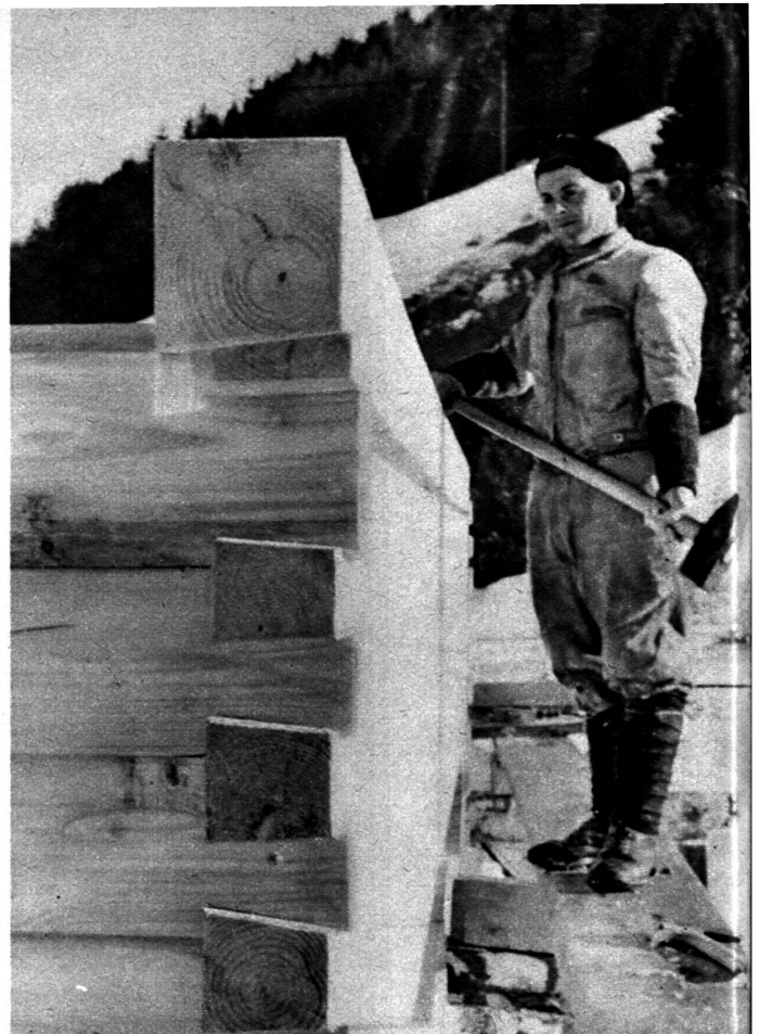
Le meilleur assemblage de madriers « à queue d'aigle » destiné à être revêtu.
