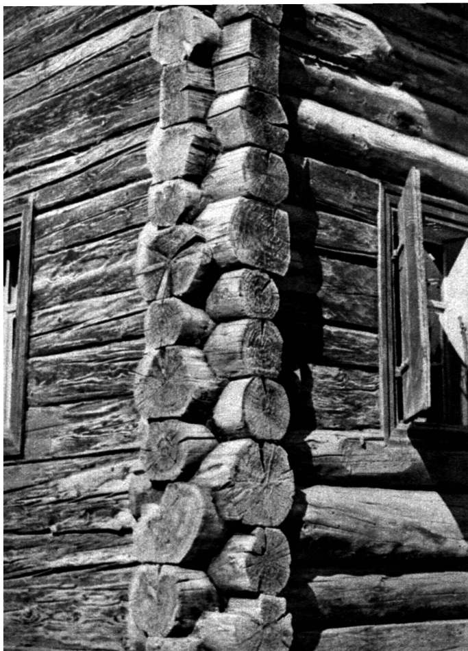
Assemblage à mi-bois ronds équerri à la hache.
