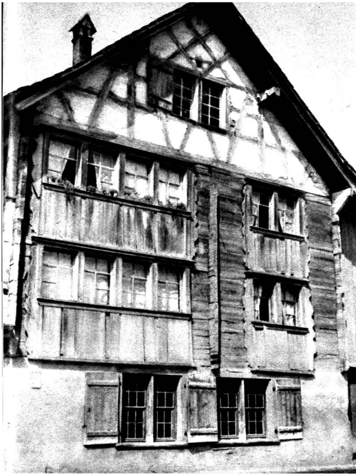
Curieux échantillonnage : Madriers, madriers avec revêtement en planches et combles en colombage.
