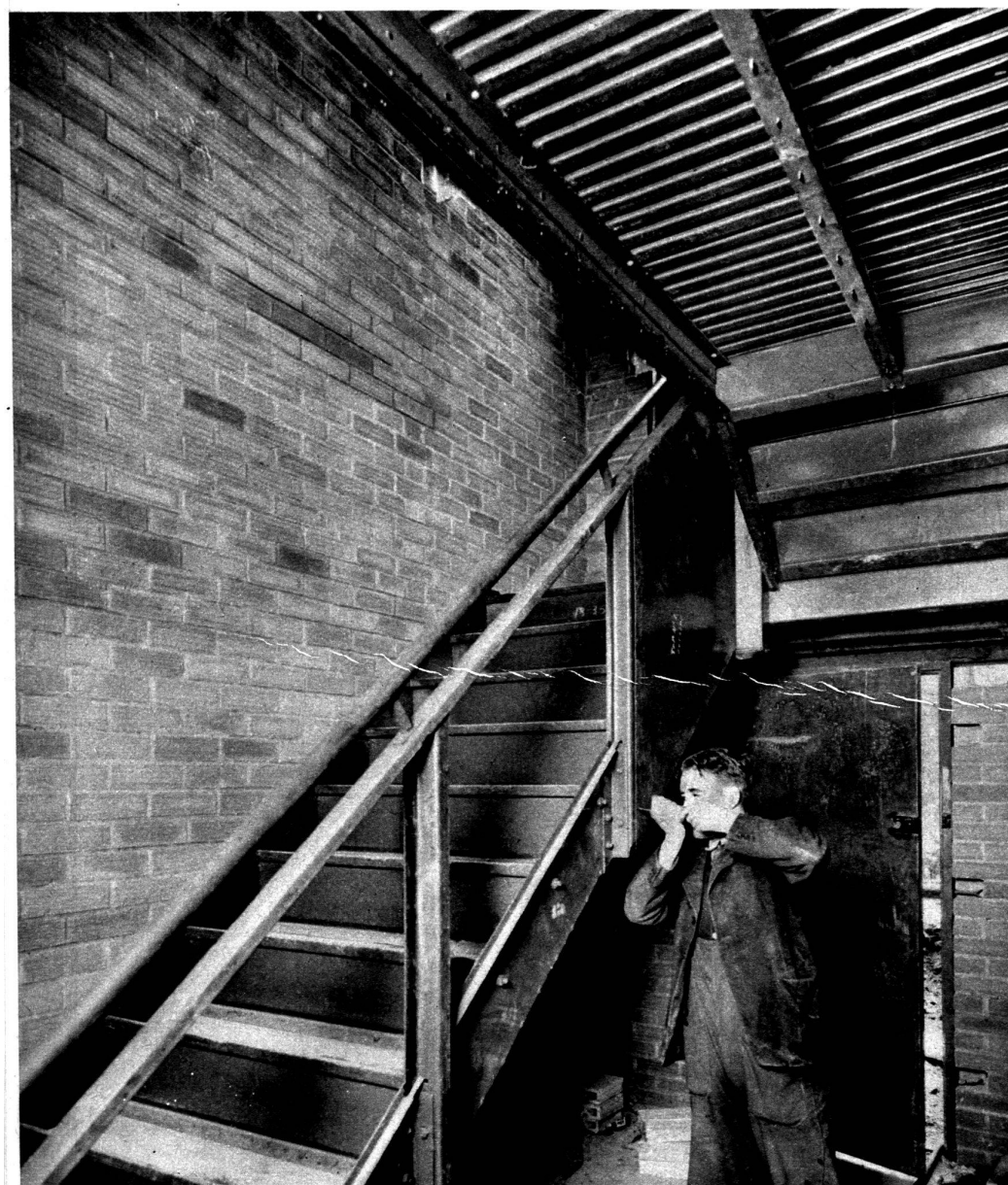
Montage de la balustrade de l'escalier.
