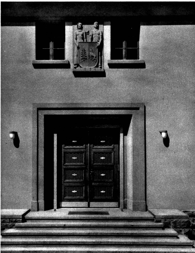
Entrée principale dans l'axe du vestibule.
