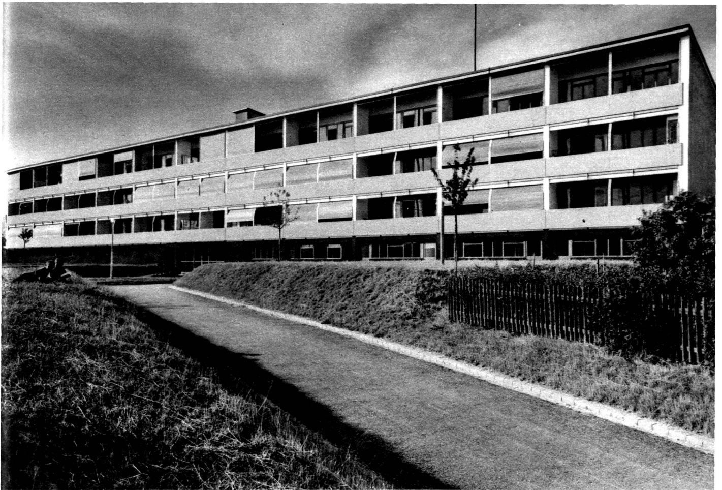
Maison collective à Neuweg-Bâle. Façade côté balcon (voir face galeries d'accès sur page de couverture).
