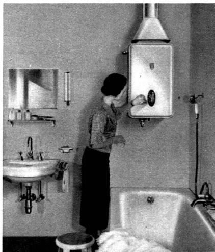
Les modèles modernes de **chauffe-eau automatique à gaz** n'ont plus de leviers ni de robinets. La mise en marche se fait en appuyant sur un bouton. Le fonctionnement est entièrement automatique : on ouvre le robinet sur la baignoire ou sur le lavabo et l'eau chaude coule aussitôt.
