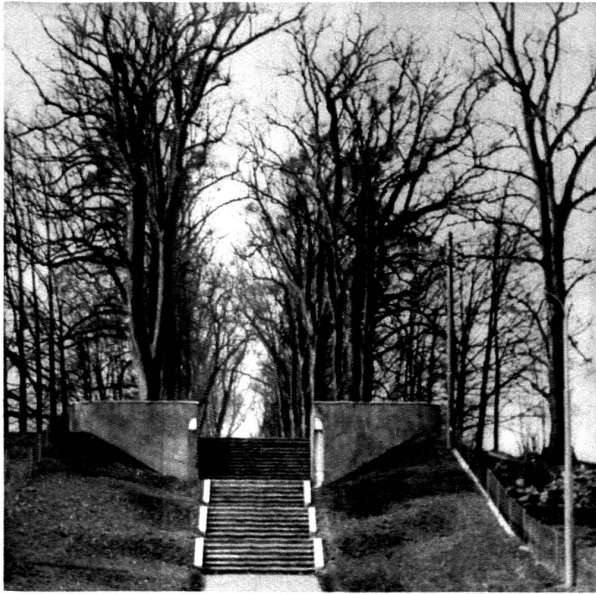
L'escalier d'accès à l'avenue
