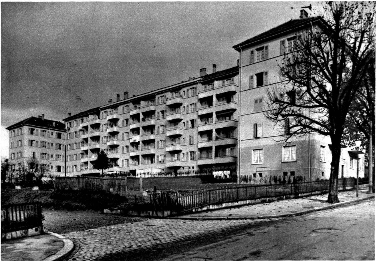
Groupe d'Ouchy : Vue du sud est.
