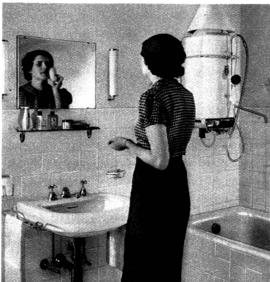
Chauffe-bains à gaz avec douche à main.
