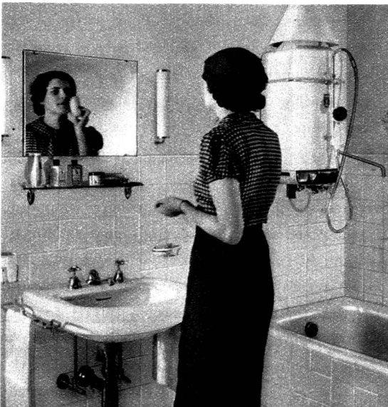
Chauffe-bains à gaz avec douche à main.
