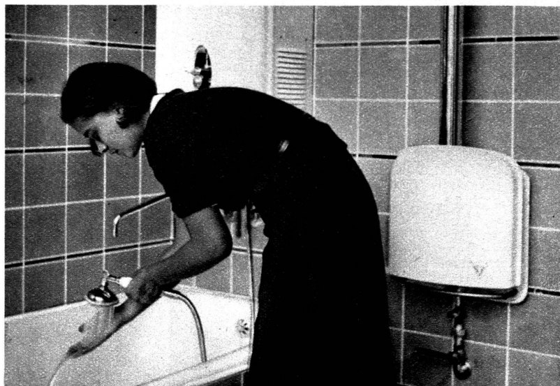
Calorifère et chauffe-bains automatique.
