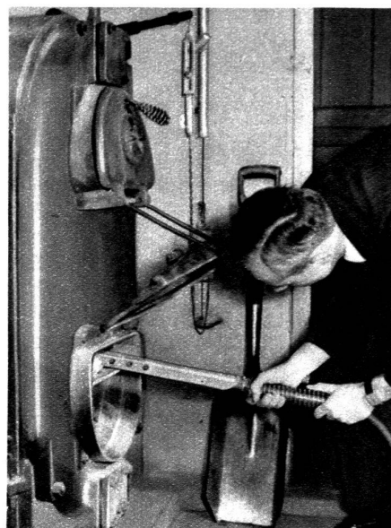
Allumeur à gaz pour chauffage central au coke.
