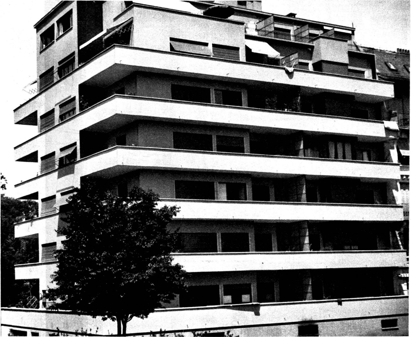
Immeuble chemin Krieg, 3. Atelier d'architectes, Genève. MM. Vincent, Saugey, Schwertz, Lesemann, architectes. 3 me prix ex aequo de la catégorie des grands immeubles.
