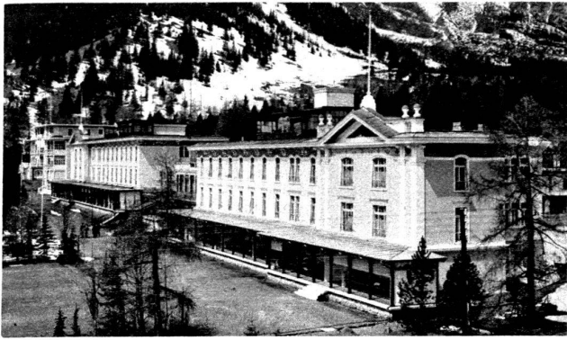
Vue générale du Sanatorium Wolfgang à Davos, avant la transformation.
