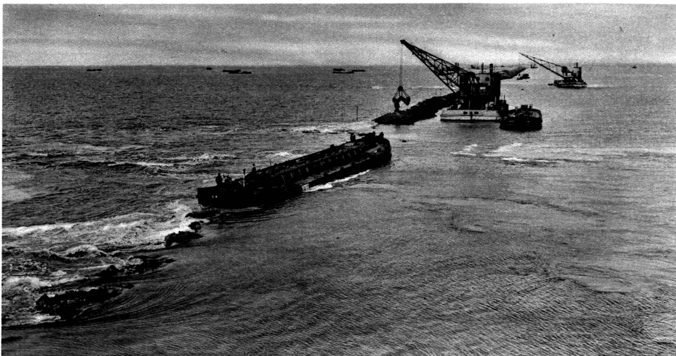
↑ La digue en cours de construction.
