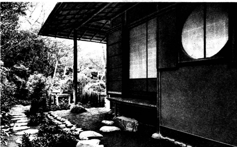
Un angle de maison avec sortie sur le jardin. On remarquera la construction de l'avant-toit en bois non équarri.
