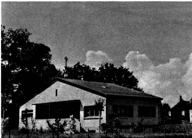
Vue angle sud-est
