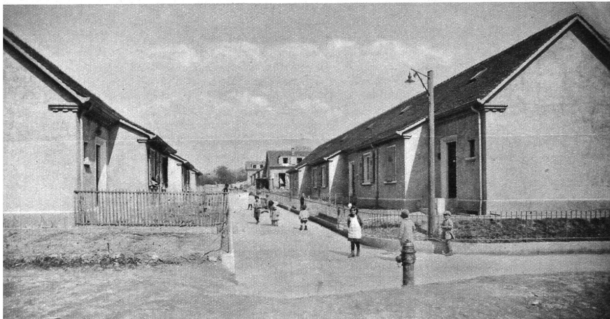
Cité-jardin de Bellevaux Société coopérative de la maison familiale à Lausanne.
