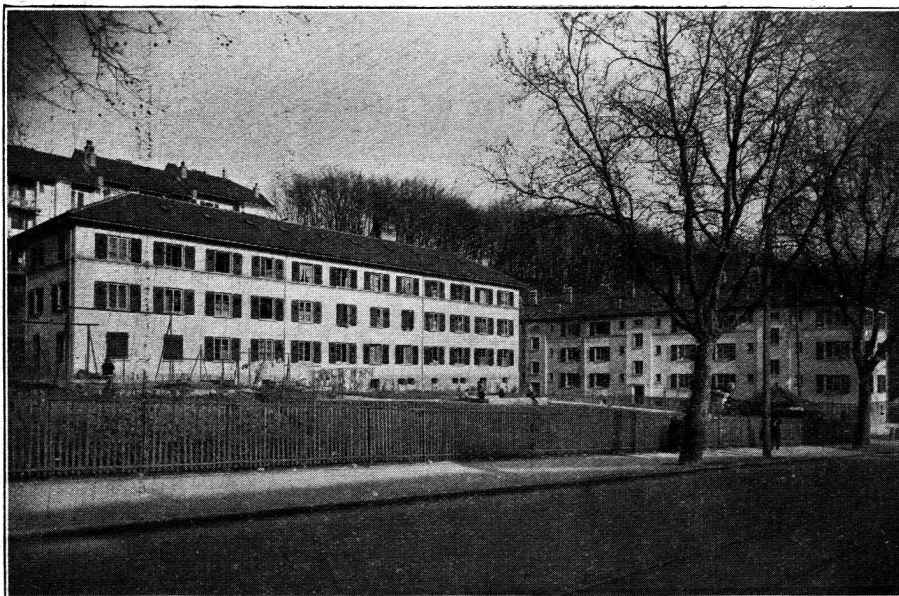
Vue prise de la rue de la Borde.
