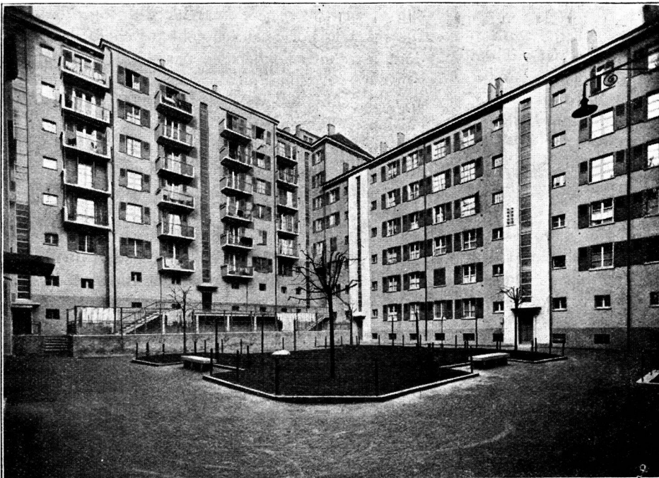
Vue de la Cour, prise de l'angle sud-ouest.
