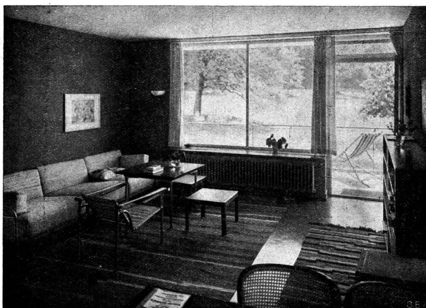
Chambre commune d'un appartement avec balcon.
